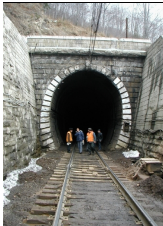
JIŽNÍ PORTÁL TUNELU BESKYD
